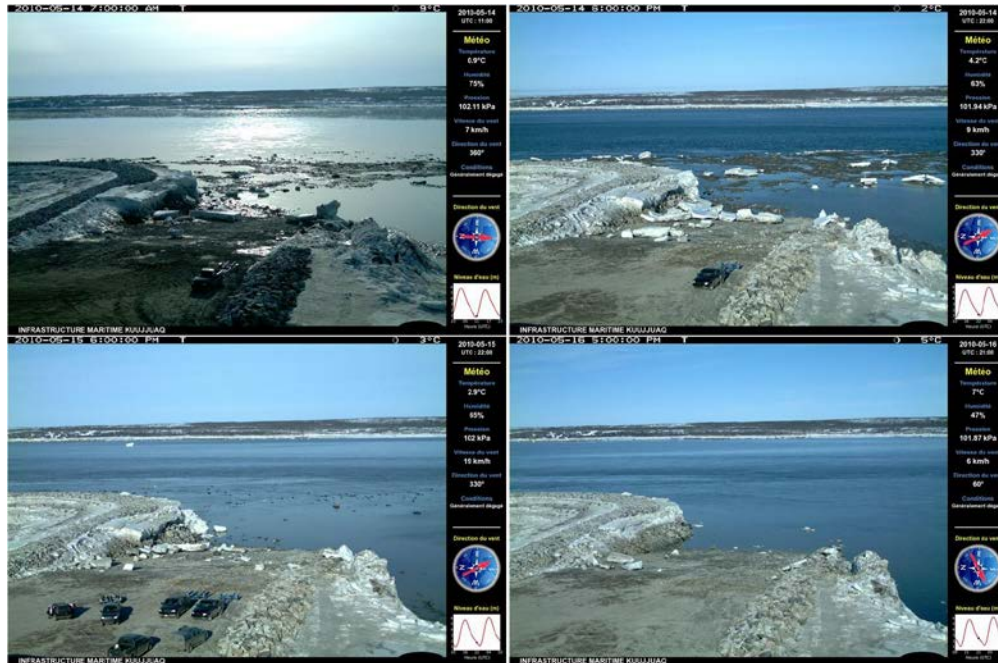
Figure 60 Dépôts de blocs de glace à proximité des infrastructures maritimes, entre le 13 et le 16 mai 2010.
