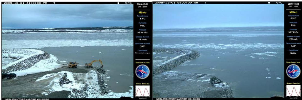
Figure 62 Dérive de glace au début de l'englacement le 31 octobre 2009. Le brise-lames de Kuujuaq est protégé par un cordon de glace mais l'eau peut le submerger.
