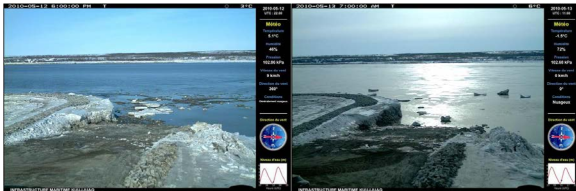
Figure 59 Dommages subis par le cordon de glace entourant le brise-lames dans la nuit du 12 au 13 mai 2010.
