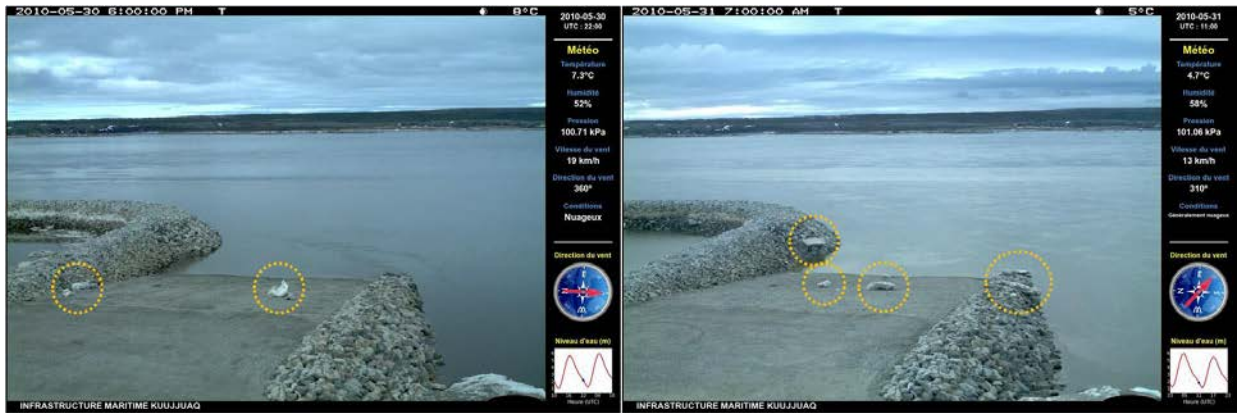
Figure 61 Dépôts de gros glaçons sur la rampe et le brise-lames de Kuujuaq, les 30 et 31 mai 2010.
