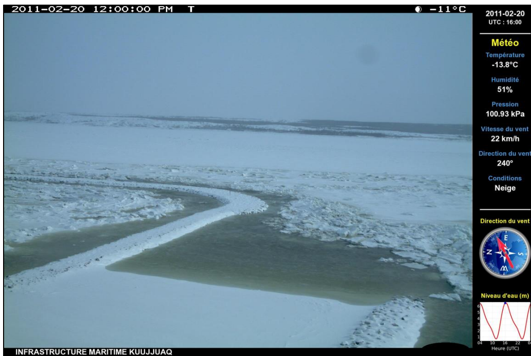
Figure 64 Le 20 février 2011, le couvert de glace est complet en face l'infrastructure et le brise-lames est protégé par un épais pied de glace. Pourtant les hauts niveaux d'eau peuvent remettre la glace en mouvement et submerger le pied de glace protecteur.
