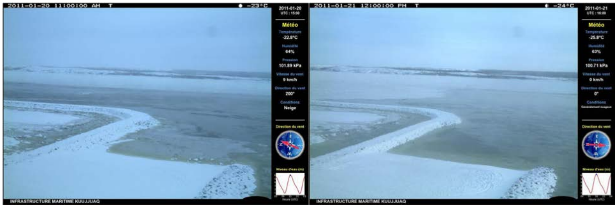
Figure 63 Dérive de glace vers la fin de l'englacement le 20 janvier 2011. Le brise-lames est protégé par un cordon de glace mais l'eau peut le submerger.
