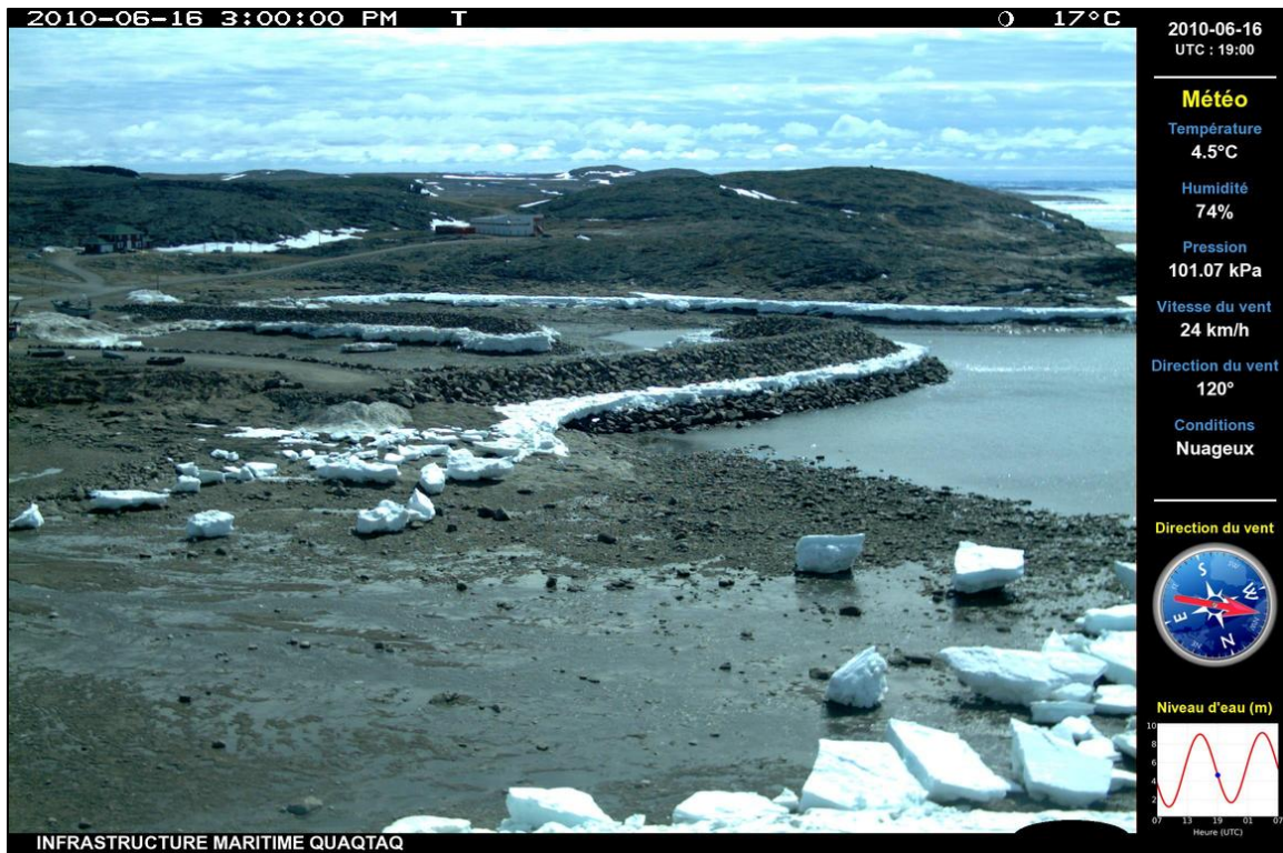
Figure 26 Cordon de glace protégeant encore l'ensemble du brise-lames de l'ancienne infrastructure (Quaqtaq, 16 juin 2010).
