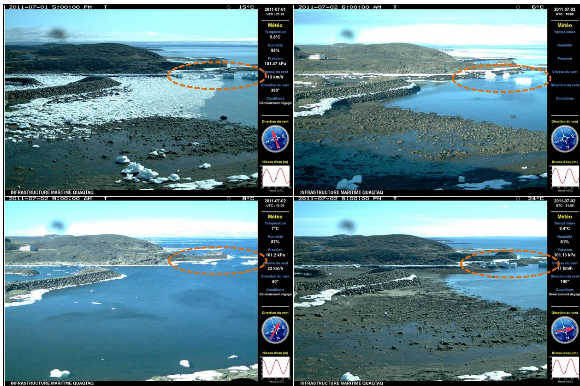
Figure 23 Gros blocs de glace en mouvement au fil des marées, à proximité des infrastructures maritimes de Quaataq les 01 et le 02 juillet 2011.
