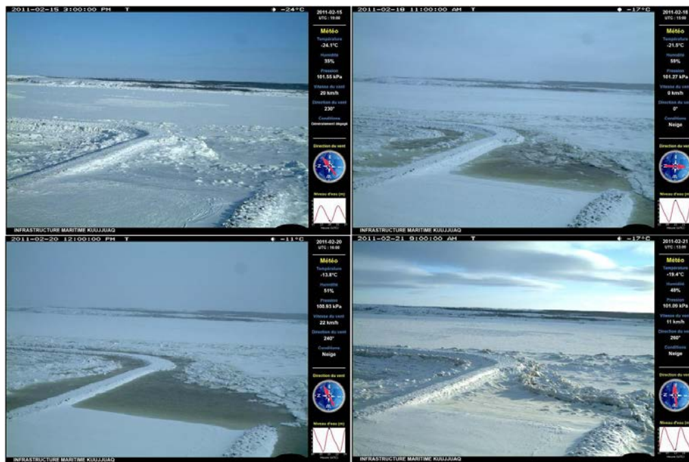
Figure 66 Forte poussée glaciaire contre le brise-lames et la rampe suite à des niveaux d'eau élevés entre le 17 et le 21 février 2011.
