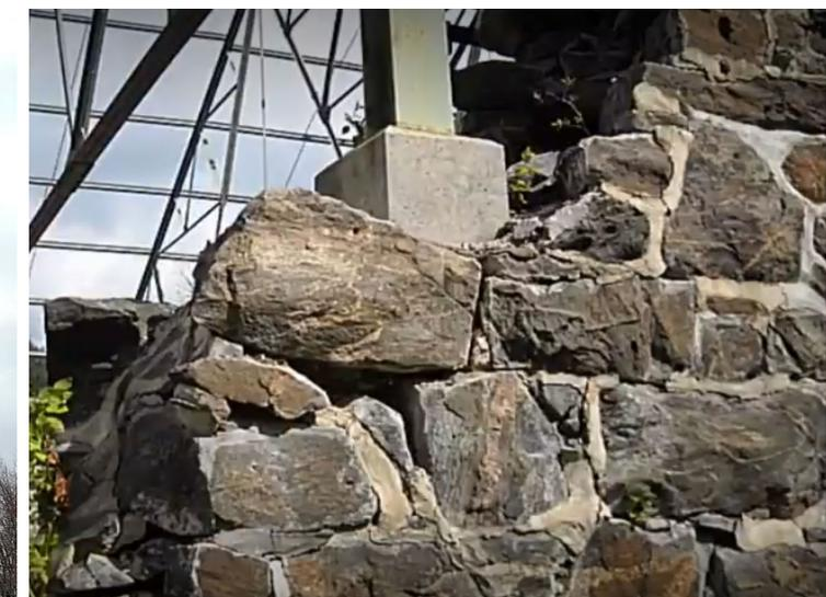
La maçonnerie de la Pulperie de Chicoutimi abîmée par les cycles de gel/dégel et les infiltrations d'eau.
